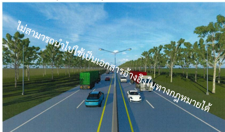
รูปที่ 6 แสดงรูปแบบที่ 2 (เกาะกลางแบบมี Concrete Barrier)
